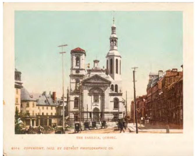
Photo de façade de la basilique de Québec.
