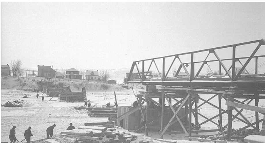
Construction du pont permanent sur la rivière Batiscan (construction terminée vers 1924).
