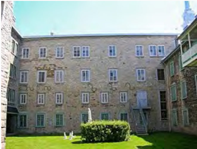
Bâtiment des Récollets de l'Hôpital général de Québec, vue latérale.
