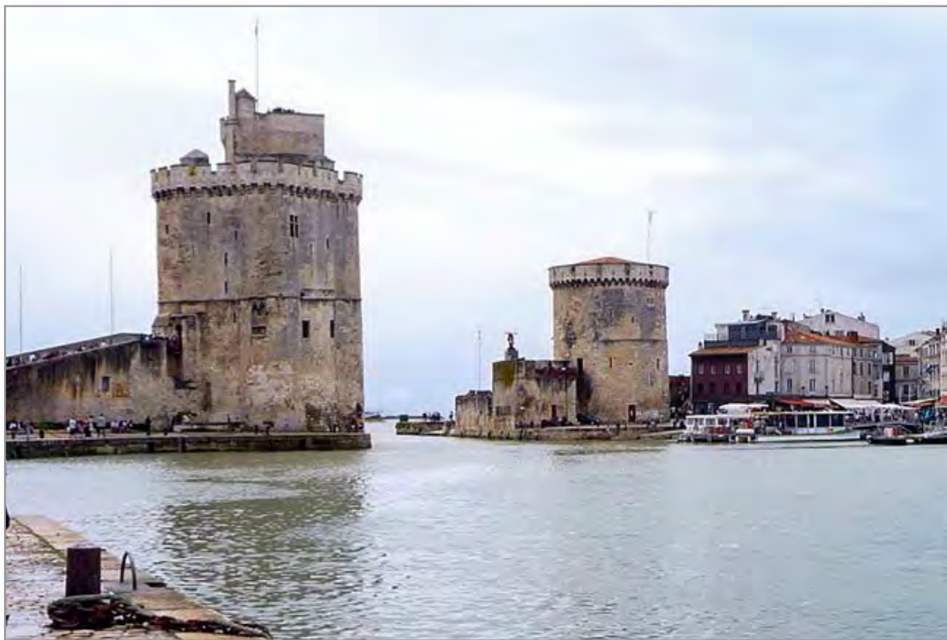
Les tours d'entrée du port de La Rochelle telles qu'on peut les voir encore aujourd'hui. Photo fournie par l'auteure.
