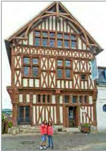
Maison à Joigny. Photo fournie par l'auteur.
