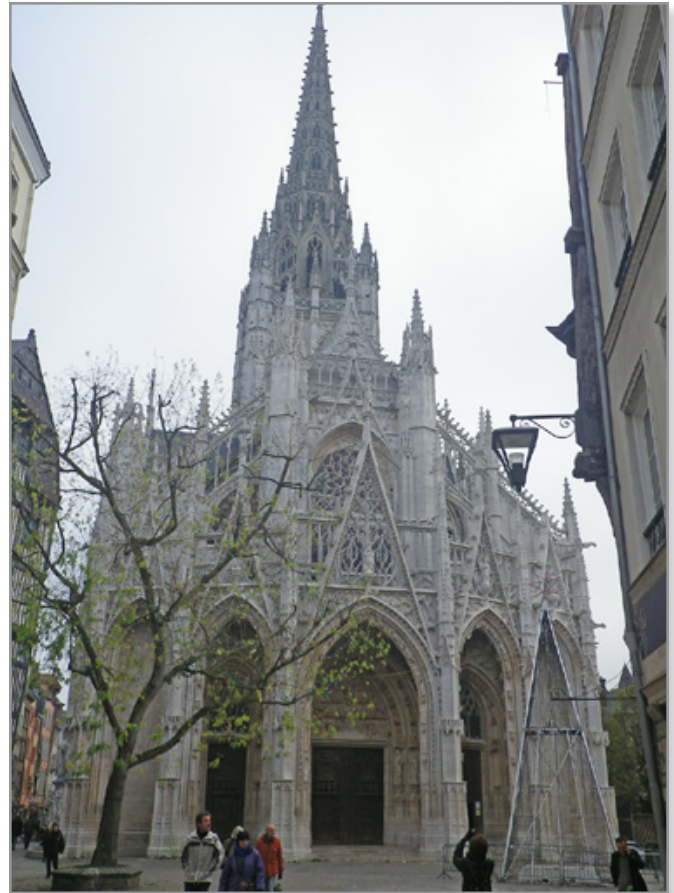
Façade de l'église Saint-Maclou.
