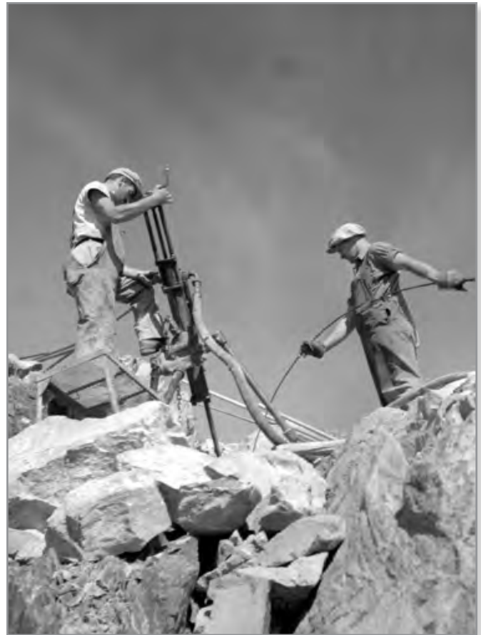
Extraction d'amiante à l'aide d'une foreuse à air comprimé à Thetford Mines, 1947, Centre d'archives de Québec, fonds du ministère de la Culture et des Communications, Office du film du Québec, cote E6,S7,SS1,P38806.
