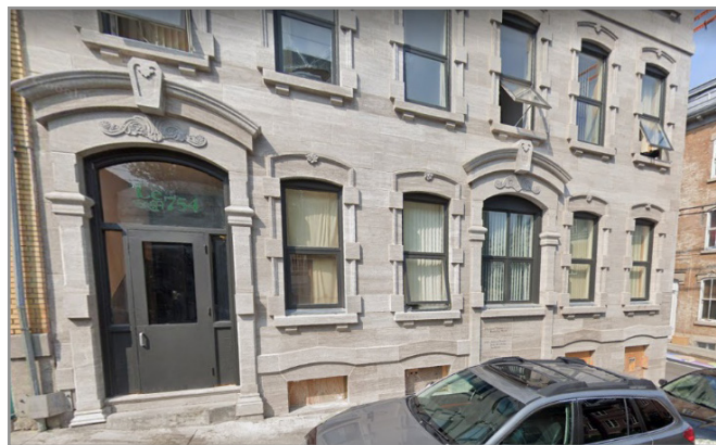
Figure 2 : Maison Thomas Pampalon, intersection Côte-Sainte-Geneviève et rue Richelieu, Québec.
