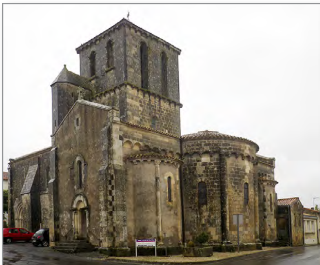
Église de Béceleuf. Photo fournie par l'auteur.
